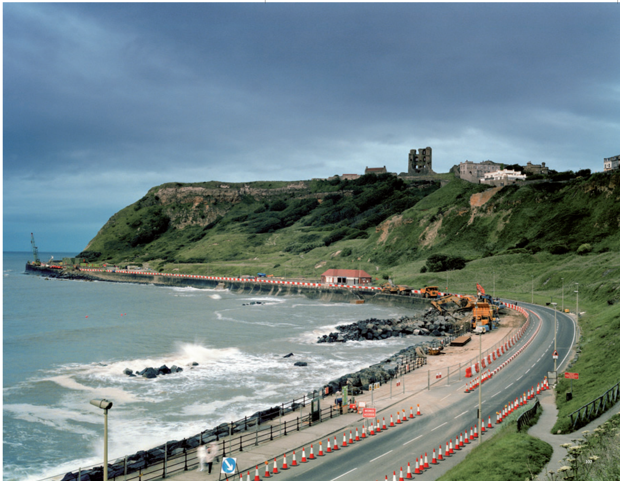
Bollwerk für den Verkehr. Wall aus Steinbrocken, Scarborough, Yorkshire
