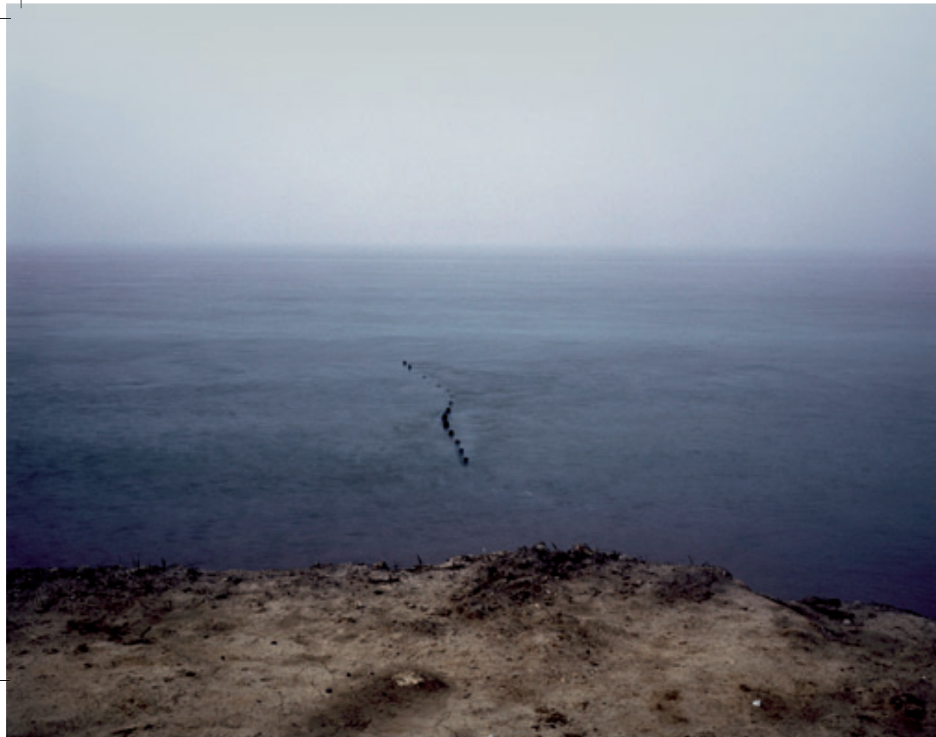
Bremse für den driftenden Sand. Bühne bei Happisburgh, Norfolk
