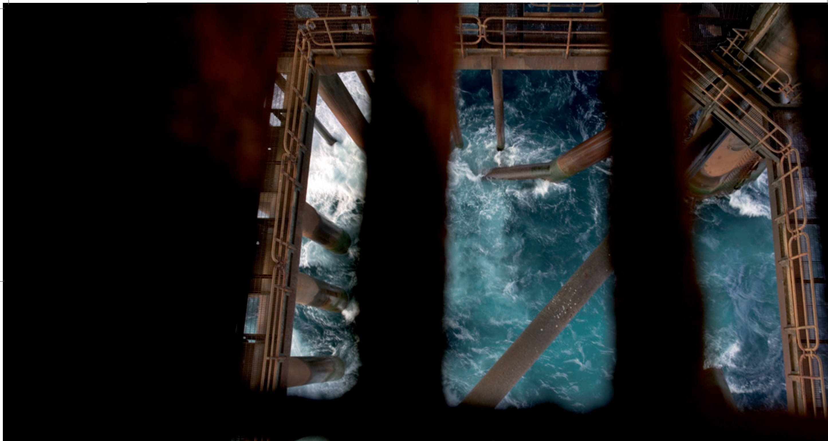
Durchblick: Der Boden auf der Plattform besteht aus Stahlgitter. 30 Meter unter den Füßen gurgelt und schäumt die See
